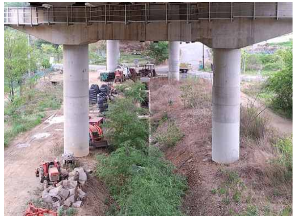
교각 P2 기초 전경
