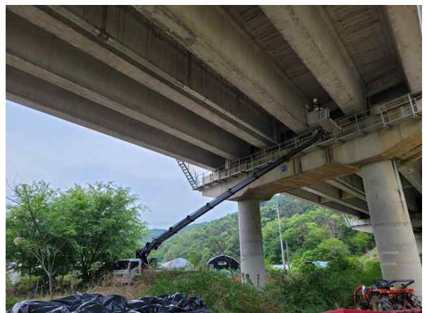
고소작업차를 이용한 근접조사
