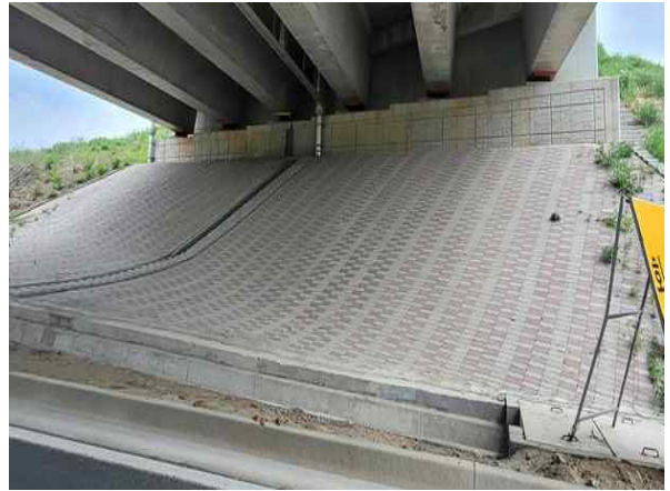
교대 A2 기초 전경
