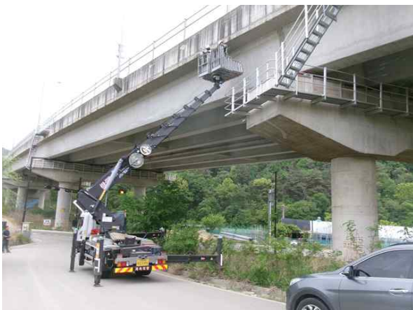
고소작업차를 이용한 근접조사
