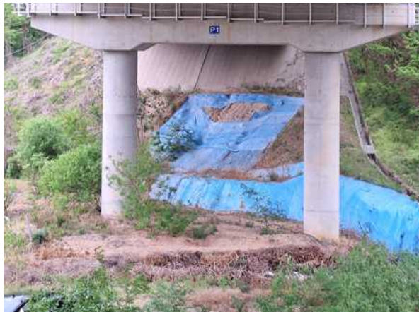
교각 P1 기초 전경
