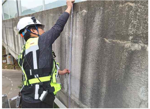
고소작업차를 이용한 부재치수 현장측정
