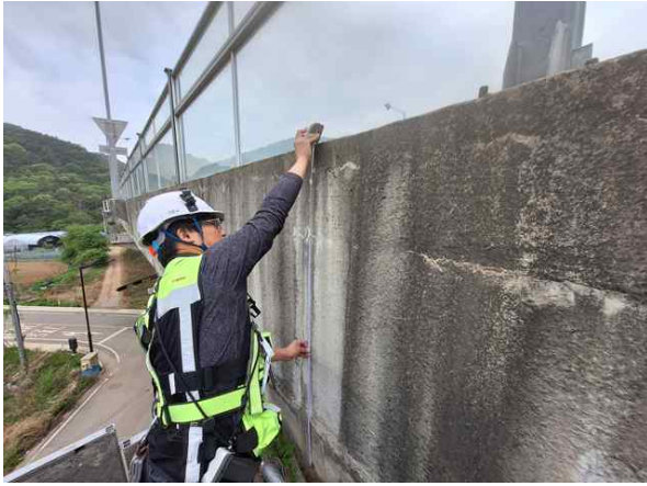
고소작업차를 이용한 부재치수 현장측정
