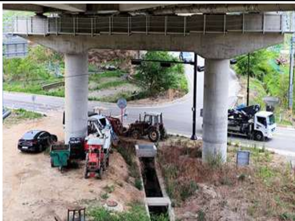
교각 P3 기초 전경
