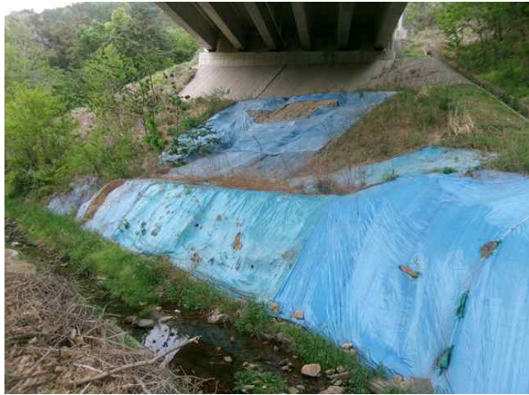
교대 A1 기초 전경
