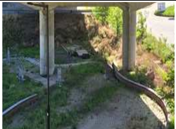
교각 P4 기초 전경
